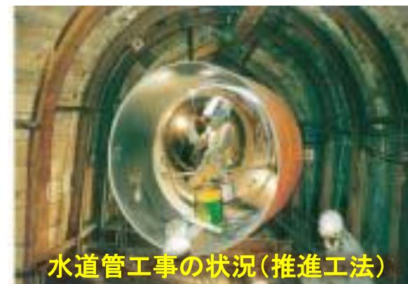
水道管工事の状況(推進工法)
