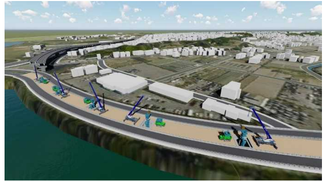
図-5 小禄道路の施工ステップモデル(基礎工の施工)
