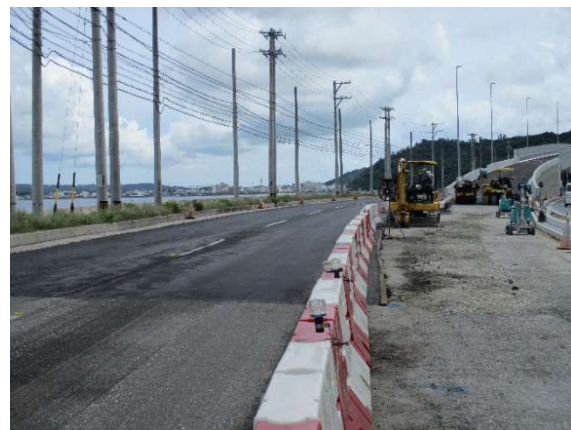
写真 - 6 仮設電柱
