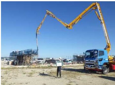
写真-2 コンクリート打設状況
