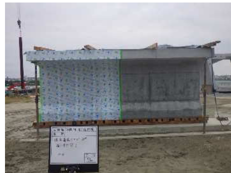
写真-3 養生テープによる養生日数の延長
