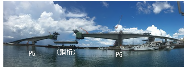
写真-1 牧港大橋混合桁施工状況
