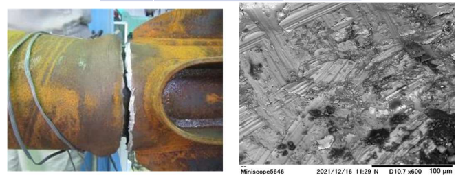
図6 No.5 の破壊の様子と SEM 画像
