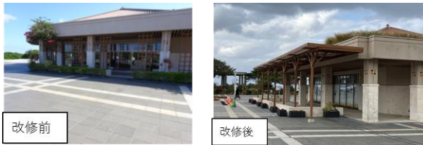
図-5 ハイサイプラザ デッキ改修状況
