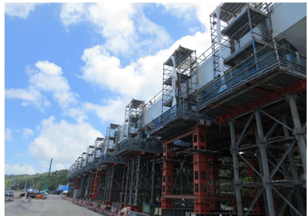
写真-3 地組みヤード
