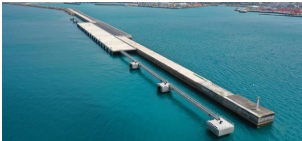
図-4 現状の岸壁部・係留部の外観
