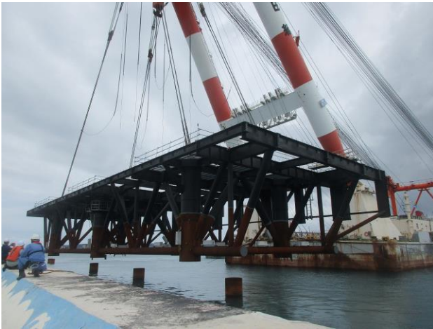
図-11 ジャケッ ト据付工事の様子
