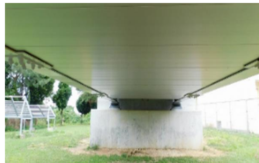
図3 琉球大学暴露場実物試験橋
