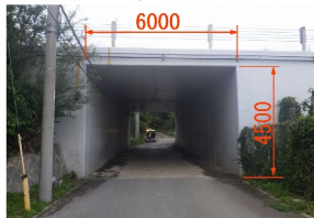
写-1 C-BOX 正面図 (海側)
