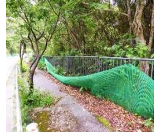
写-10 クイナフェンスの破損状況
