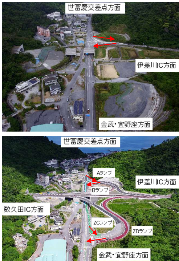
写真-1 世富慶 IC (上:施工前 下:施工後)
