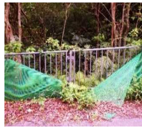
写-10 クイナフェンスの破損状況
