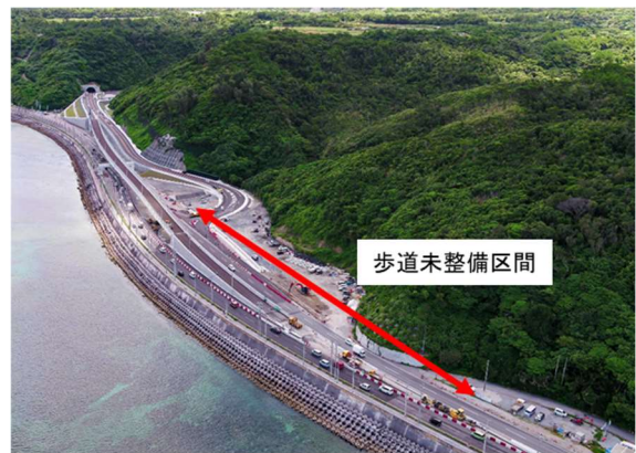
写真 - 5 歩道未整備区間
