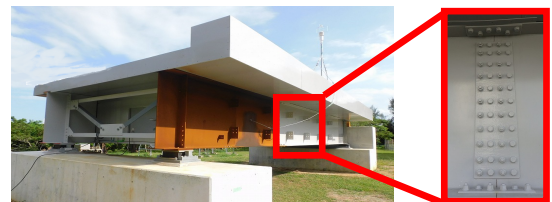
図 2-1 対象橋梁と計測したボルト継手部
