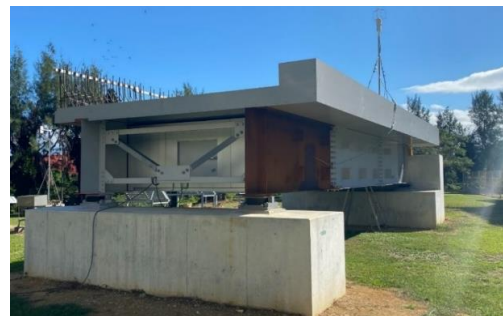
図2 琉球大学暴露場実物試験橋
