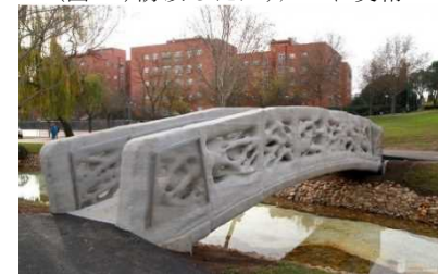
(図 18) 3D プリンターで出力した歩道
