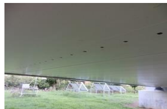
図6 デッキ下面計測孔
