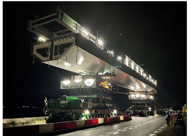
写真-2 夜間一括架設
