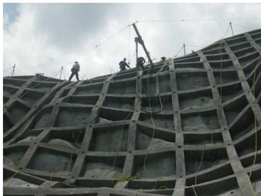
写真－14 ロックボルトの施工状況
