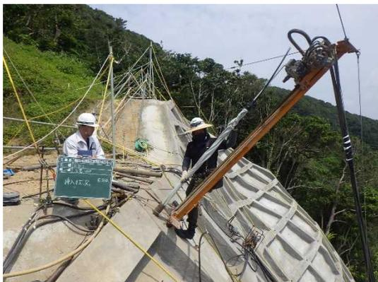
写真－13 ロックボルトの施工状況
