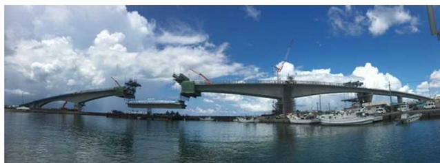
写真-1 牧港大橋混合桁施工状況
