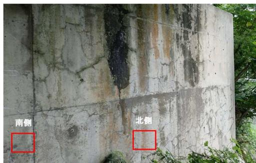
図-3 ひび割れ状況及び調査箇所
