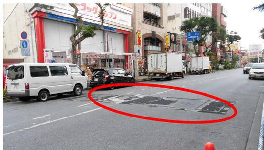
写真4 ガープ川ボックス点検口
