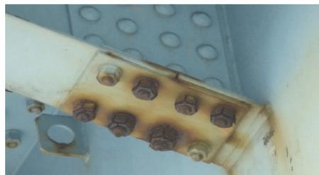
写真 1 高力ボルト継手部の腐食損傷事例
