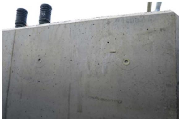
写真9 沈みひび割れ・表面気泡
