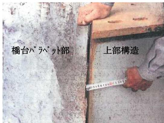
写真6 A2 橋台の遊間量(20mm)
