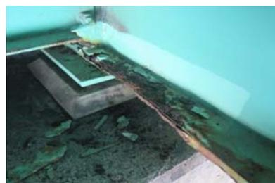
写真1 補修箇所からの再劣化例
