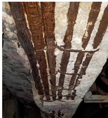
写真3 桁下の鉄筋露出箇所（端部の桁）
