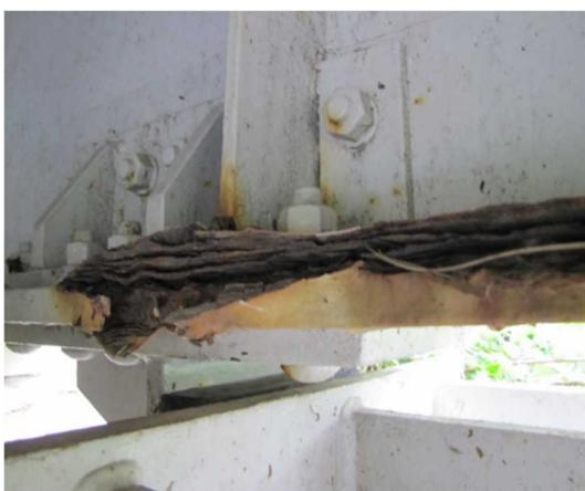
写真2 主桁下フランジ部の腐食
