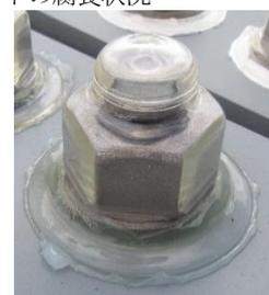
写真3 透明型防錆キャップ
