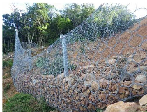
写真-8 落石防護柵設置後の状況
