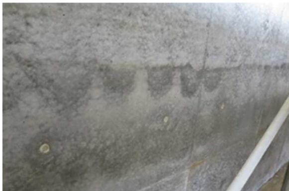
写真8 打ち重ね線と過振動による模様
