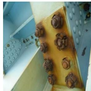
写真1 高力ボルトの腐食状況
