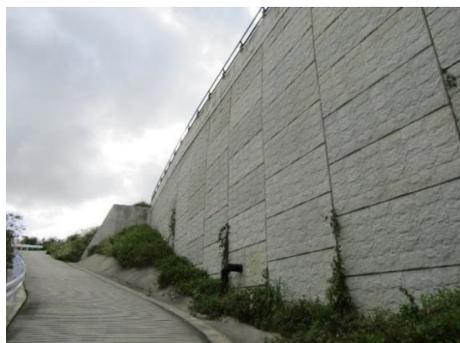
図 1 テールアルメ工法の擁壁外観
