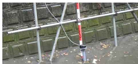
写真5 水位検知システム設置状況
