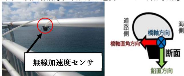
図4 無線加速度センサ 設置位置
