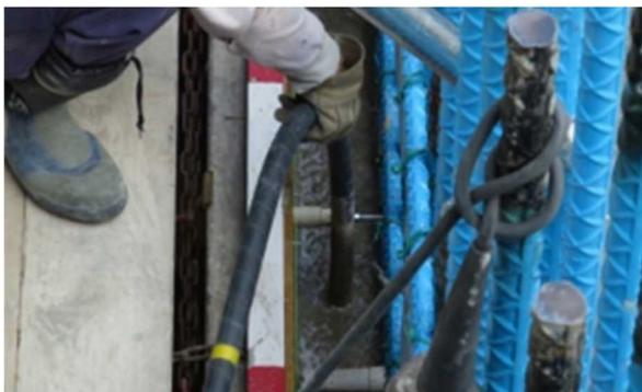
写真6 かぶり箇所の締め固め
