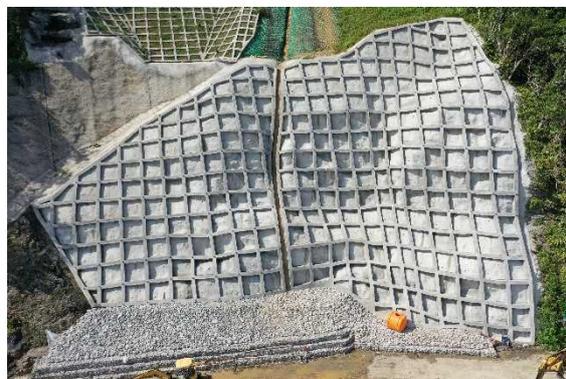
写真-7 ロックボルト施工後の状況
