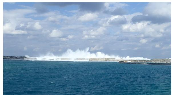
図2 埋立地北側工区護岸 越波状況 (2016. 11. 9 撮影)
