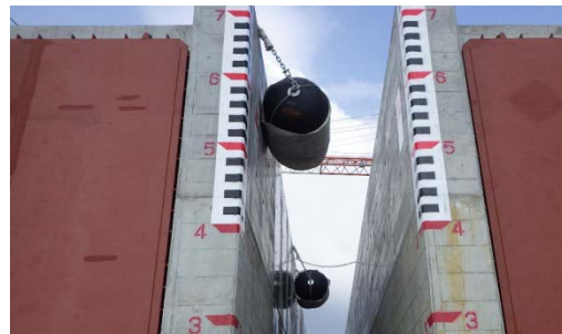
写真 12. 空気式防舷材敷設状況
