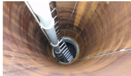
写真 9. アクセスシャフトより注水作業
