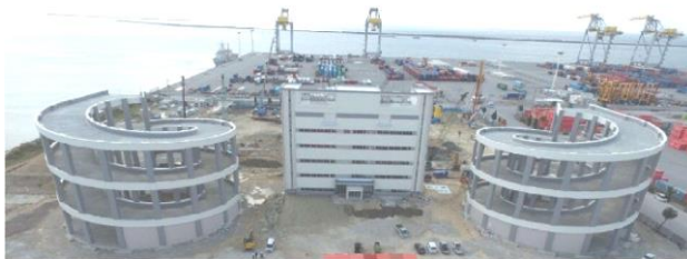
写真5. 那覇港総合物流センターの整備状況 4)
