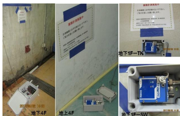
写真-3：加速度計の設置状況
