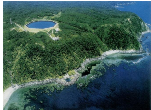
写真-1：沖縄やんばる海水揚水発電所
