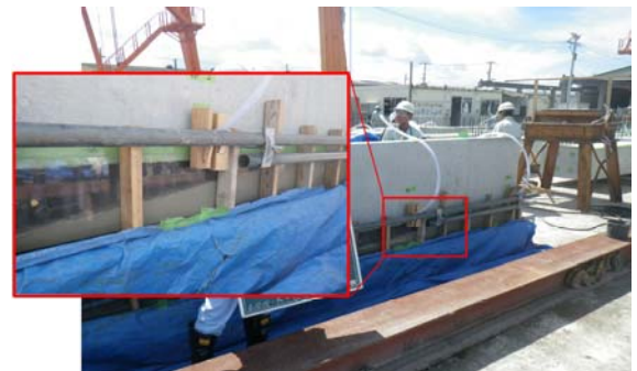
図-13 試験施工状況
