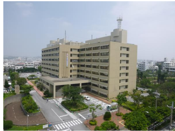
図 2 那覇第1地方合同庁舎の全景
