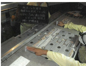
図-13 軌道整備要領による測定
