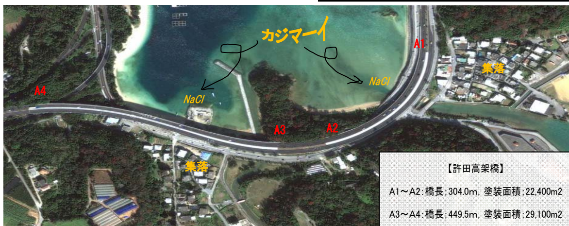
図-1 沖縄自動車道 許田高架橋
