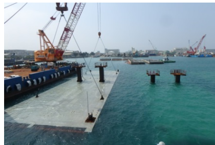
写真 10. 注水作業中（右側は水中仮置き中のカルバート）
