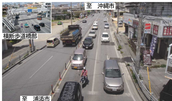
写真-1 整備前の状況
