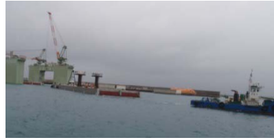
写真 8. カルバートより進水引出中
