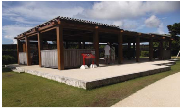
図-7 銭蔵跡の休憩施設
