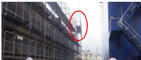
写真 11. 作業足場（ユニット化）解体 (b) クレーン等の安全対策
