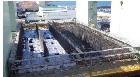
写真 2. 12,000 t 級 FD での製作状況 (鉄筋組立)
