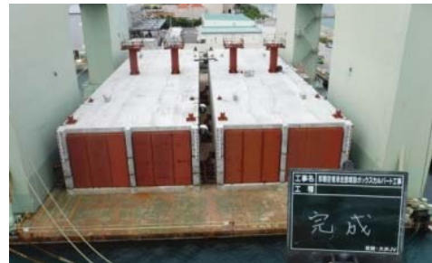
写真 3. ボックスカルバート完成写真
