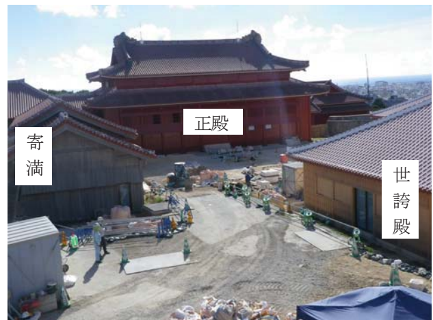
図-19 御内原整備イメージ（上） 現在の御内原エリアの施工状況（下）
