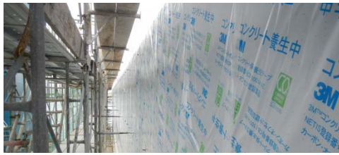
写真 7. 保水養生テープによる養生
