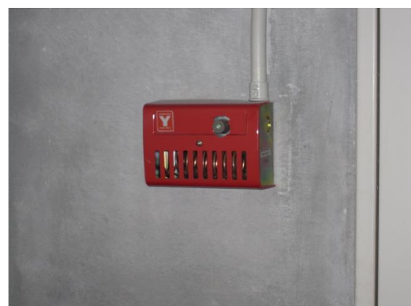
図5 換気ファン用温度センサー
