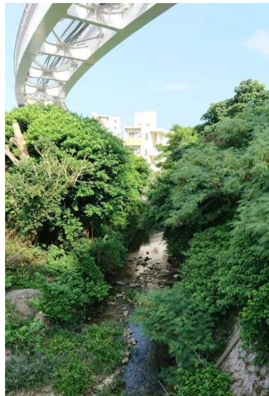
図 2. 安里川の水位計設置箇所（ひめゆり橋）。右下に見えるパイプが水晶式水位計。
