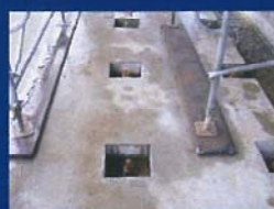
フーチングのPC鋼棒に よる縦締め
