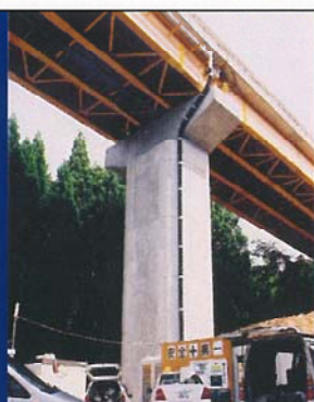
安津見高架橋・柱部 (PC鋼材巻立て)
