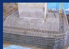
フーチングのPC鋼より線に よる横締め
