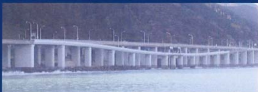
予防保全として実施した表面被覆工法の事例 (北陸自動車道 親不知海岸高架橋A, Bランプ, 昭和61年施工)
