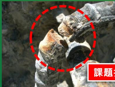
コンクリート中の鉄筋破断
