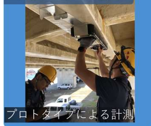
橋桁下部からの計測
