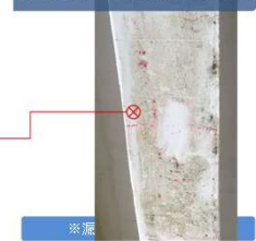
推定された破断箇所
