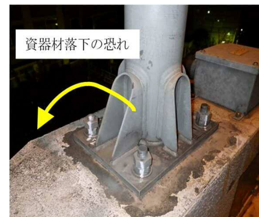
背面に遮音壁のない箇所の照明柱
