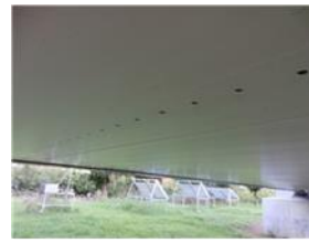
図 2-1 デッキ下面風圧計孔
