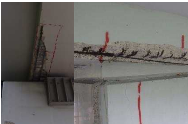
図-1 幸喜橋(中央径間：非合成鈹桁部)
