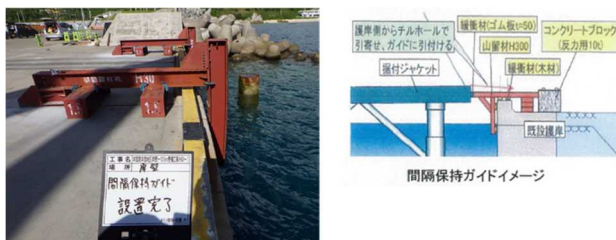
写真3 間隔保持ガイド設置
