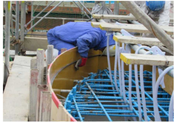
写真12 モルタルの拭き取り状況
