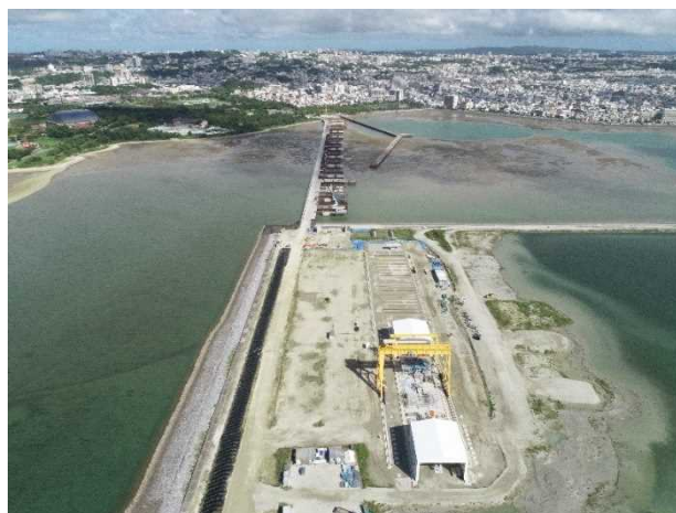
写真15 施工状況写真(令和2年8月)
