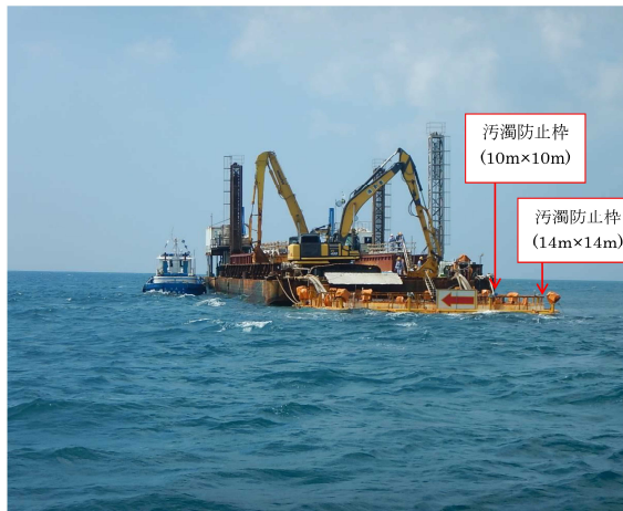
(写真 汚濁防止枠 展張状況)
