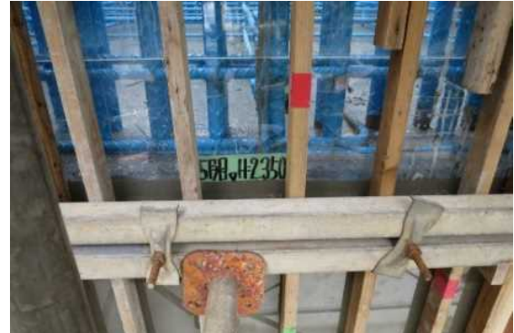
写真7 打設高さ確認
