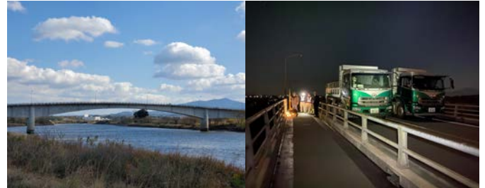
図2 対象橋梁全景および載荷試験
