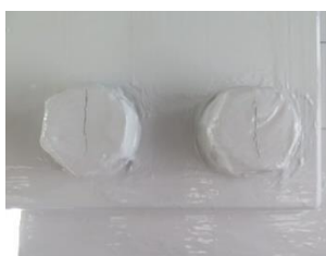
写真 3 透明型防錆キャップ施工時(2019年6月)
