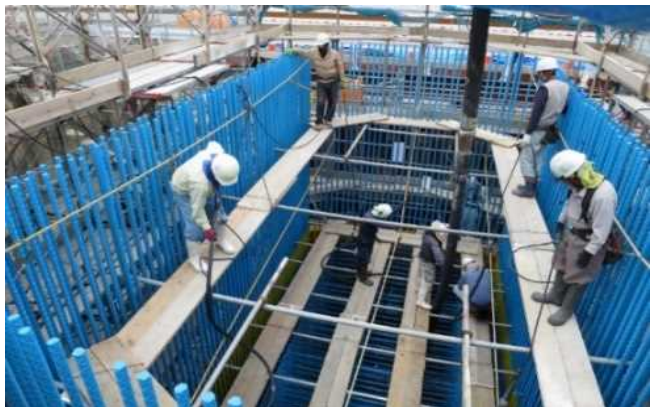
写真4 2段式足場による締固め
