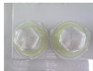
写真 3 透明型防錆キャップ施工時(2019年6月)
