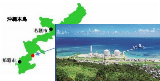
図-5 吉の浦火力発電所
