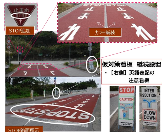
図-7 地点1交差点への恒久的な安全対策
