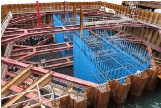
写真13 火打ち直下での施工(遠景)
