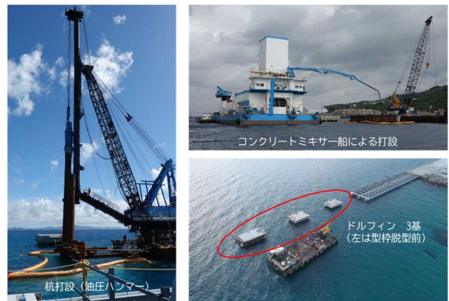
写真6 ドルフィン施工状況
