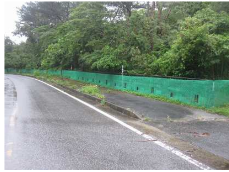
写真-3 クイナフェンス設置状況
