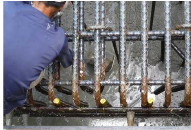
写真10 ブリーディング水の除去
