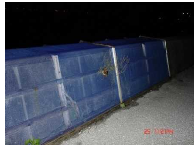
写真-8 カニ渡りネットの設置状況
