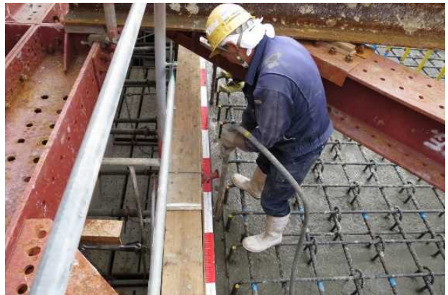
写真3 かぶり部の締固め状況
