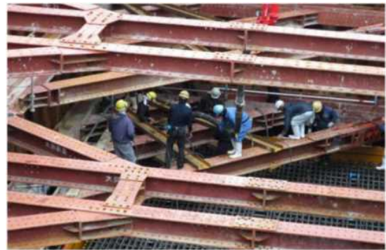
写真14 火打ち直下での施工(近景)
