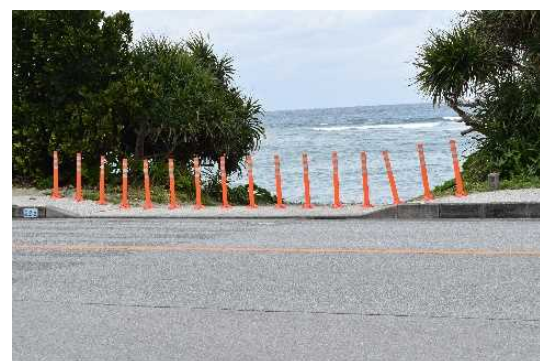
写真-10 ソフトポールの設置状況
