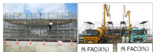
写真-1 打設試験体および打設状況
