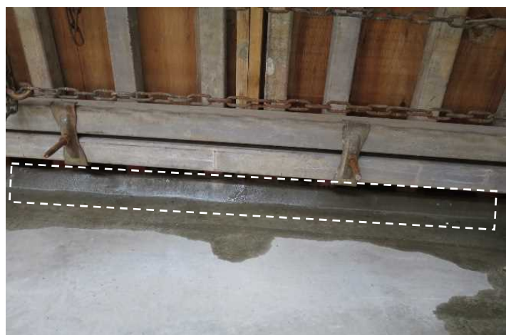
写真9 境界のモルタルによる目止め
