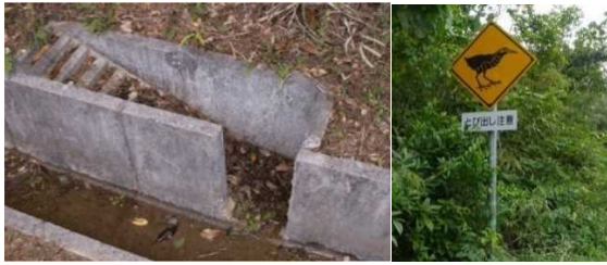
写真-6 小動物保護型側溝(左)のクイナ標識(右)設置状況
