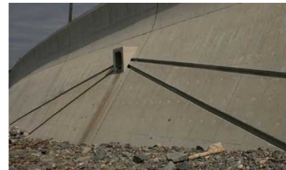
写真-9 護岸スリットの設置状況
