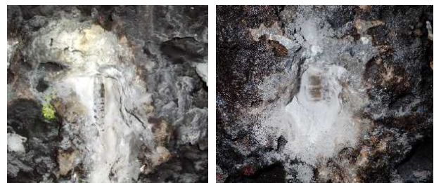
図-5 鉄筋調査写真
