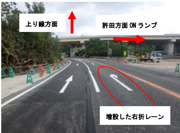
図-3 許田方面 ON ランプ入口部交差点改良後
