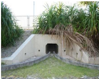
写真-7 カニさんトンネルの設置状況
