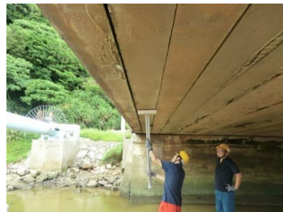
〔写-2-8 着磁作業状況〕
