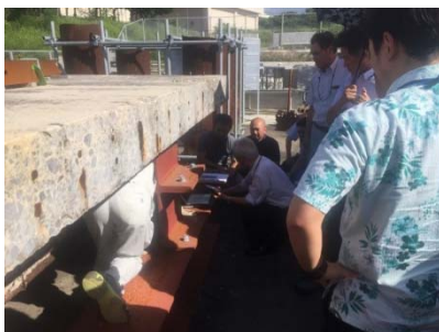
〔写-1-3 A I 打音検査実施状況 1〕
