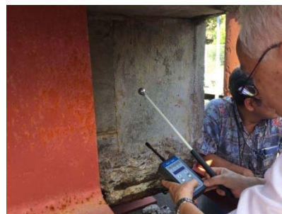
〔写-1-4 A I 打音検査実施状況 2〕
