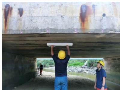
〔写-2-9 非破壊検査測定状況〕
