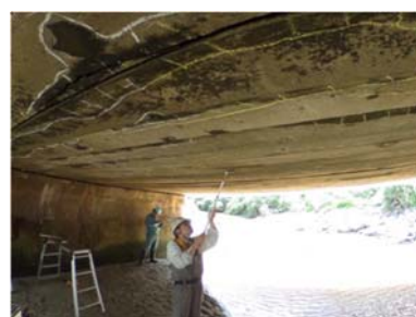
[写-2-6 目視点検マーキング作業状況 2]
