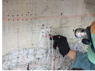
[写-2-2 塩分センサによる測定状況]
