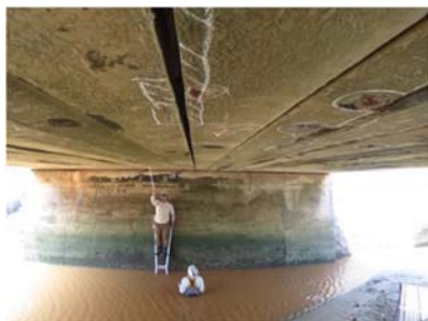
[写-2-5 目視点検マーキング作業状況 1]
