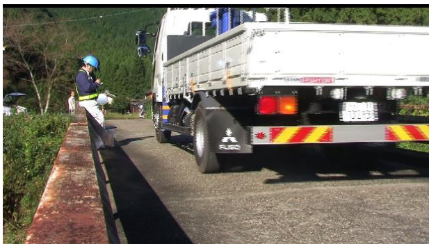
図2 走行試験の様子および試験車両
