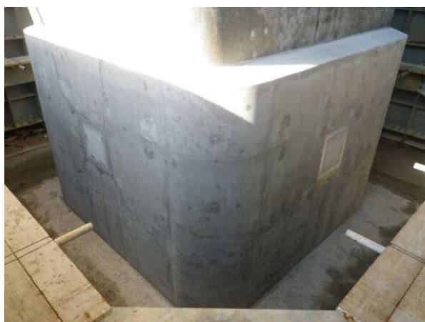
写真-4 RC 巻き立て完了後
