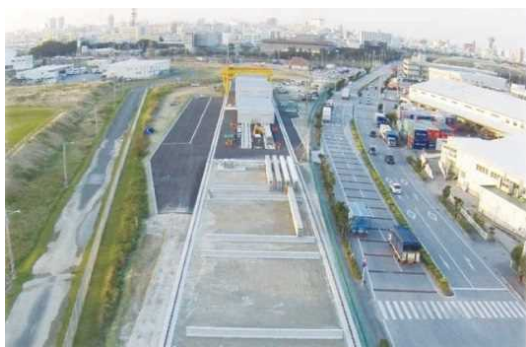
PC 軌道桁製作場(浦添西洲)
