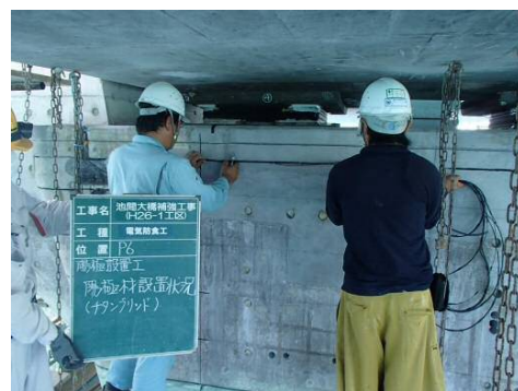
写真-2 陽極材設置状況
