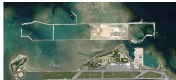
図－1 3 那覇空港進捗状況（平成28年11月現在）
