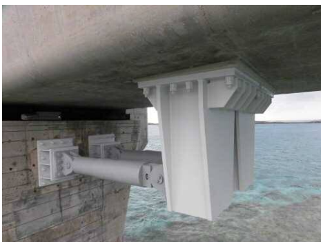
写真-6 ダンパー設置完了後
