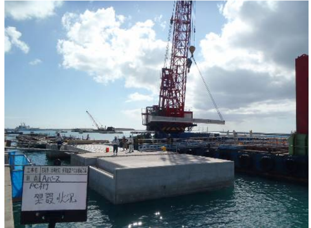
図-12 PC 歩廊桁架設
