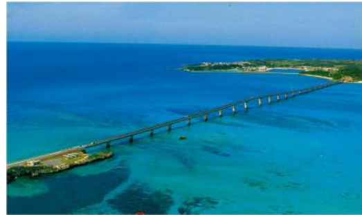
写真-1 池間大橋全景
