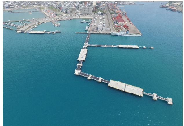
図-13 係留施設完成状況
