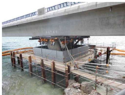
写真-3 鋼板仮締切完了後
