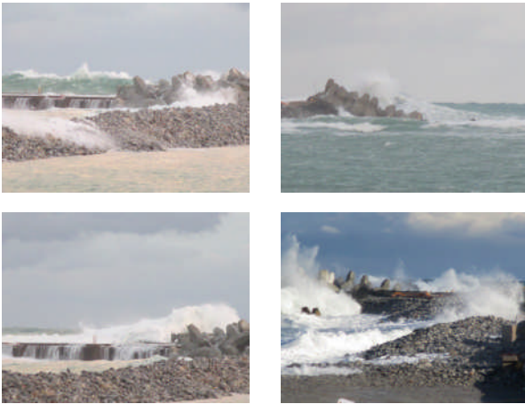
図－3 傾斜堤護岸への高波浪の来襲
