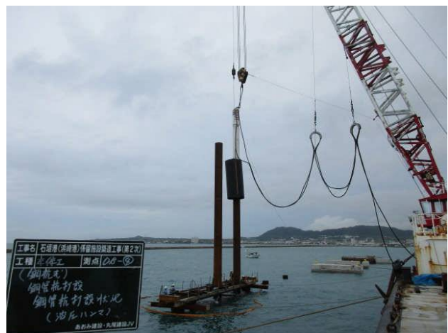
図-8 鋼管杭打設
