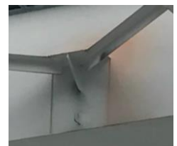
写真 4 ガセットウェブ接合部
