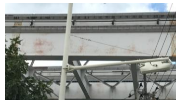
写真 1 鋼軌道桁ウェブ
