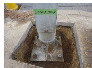
写真－1 掘削点検の状況
