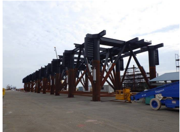
図-6 ジャケット製作
