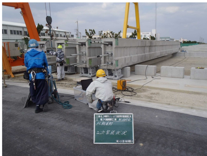
PC軌道桁緊張状況
