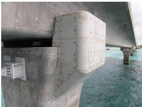
写真-5 支承補強工完了後
