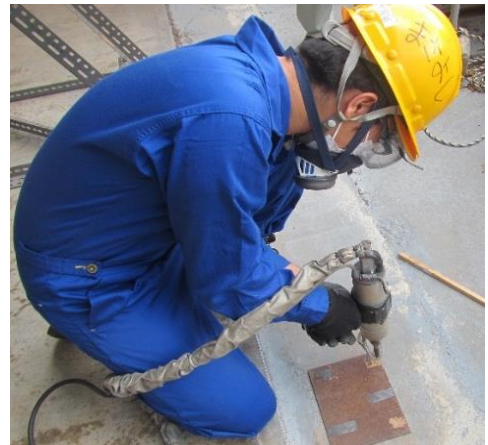
写真-2 CS 施工風景
