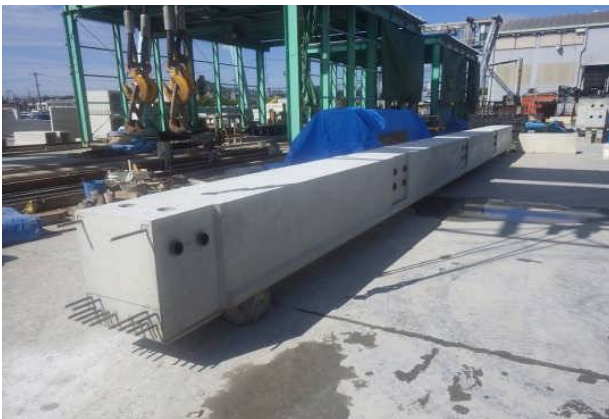
図-11 PC 歩廊桁工場製作
