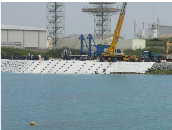
図－7 防砂シート敷設状況について
