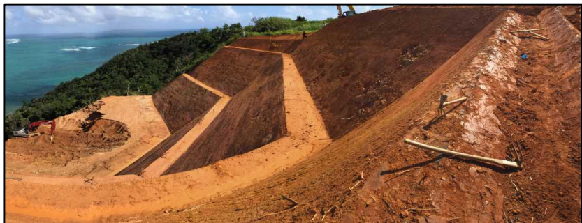
写真-3 源頭部切土工・法砕工（平成 28 年 9 月時点）
