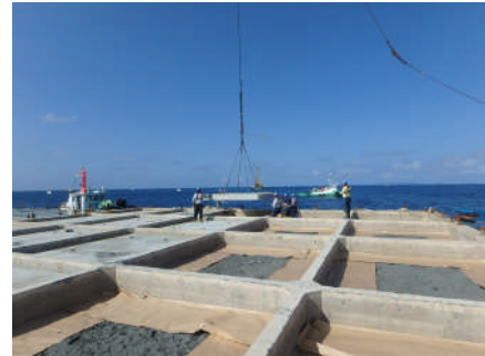
図－9 ケーソン蓋コンクリート設置状況
