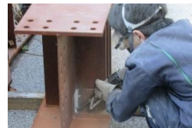
写真-3 CS 施工風景
