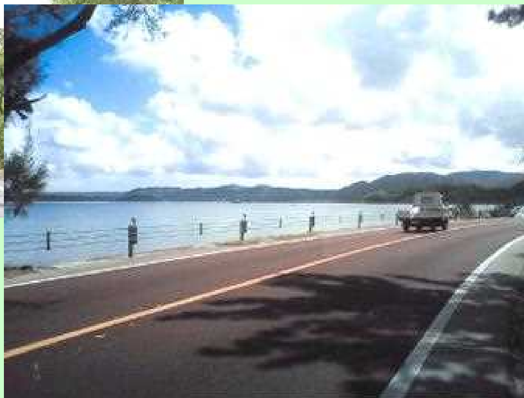
↓ 交通安全施設：防護柵
