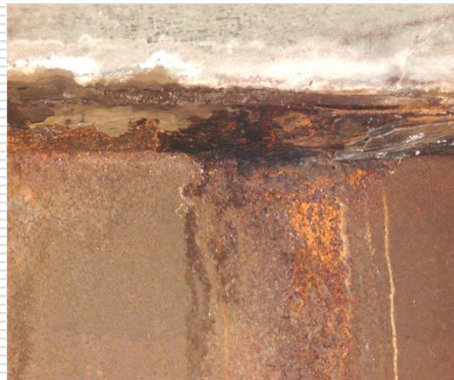
さびが一様でなく、断面欠損を伴う
