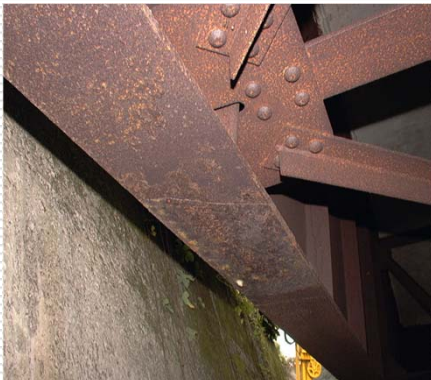
さびが一様でなく、断面欠損を伴わない
