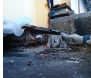
桁端部と支承部のみが腐食(ジョイント漏水)
