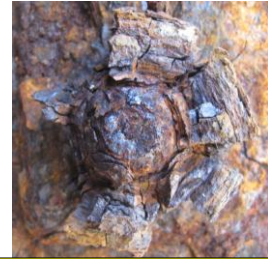
通称: パラが咲いているボルト
