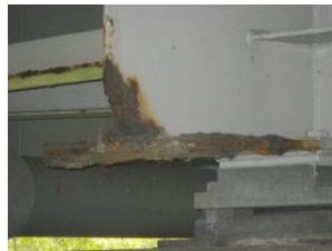
桁端部と支承部のみが腐食(ジョイント漏水)
