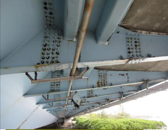
ボルト添接部のみ錆び・腐食
