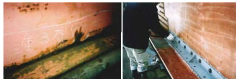
◆主桁溶接部の腐食 ◆補強材取り付け状況
