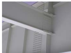
◆腹板や横桁の腐食状況を観察する
