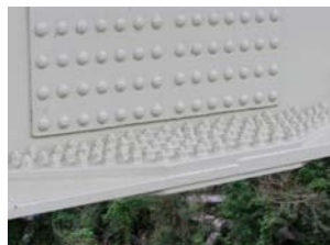
◆ボルト添接部の状況
