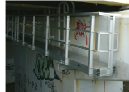
◆点検通路(海岸沿い) ◆点検通路(海岸から250m) ◆アルミ検査路(海岸沿い)
