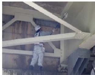
◆モップによる桁内部の洗浄
