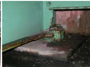
◆桁端部の腐食③
