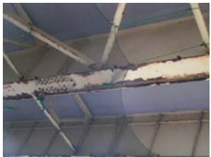
◆下フランジ角部の腐食
