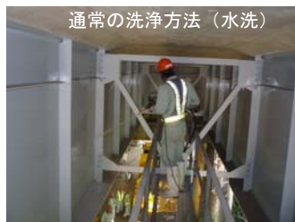
◆高圧洗浄機による桁内部の洗浄
