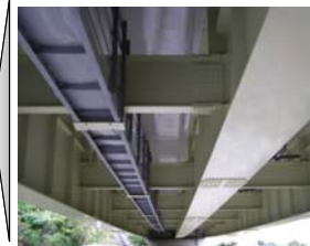
◆桁内部の状況
