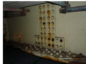
◆ボルト継手部の腐食
