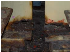
◆桁端部の腐食①
