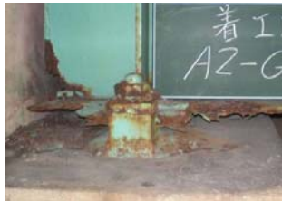
◆桁端部の腐食②
