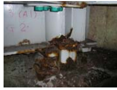
◆直下の鋼支承の腐食
