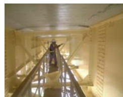
◆鋼主桁内面の水洗
