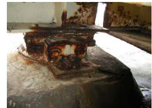
◆鋼支承部の腐食
