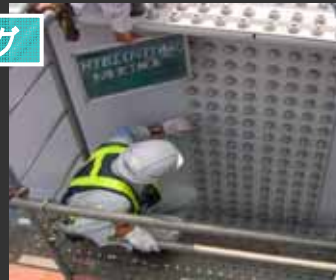
【締付け完了検査の様子】
