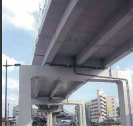
【鋼細幅箱桁橋】
