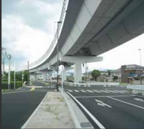
【開断面箱桁橋】
