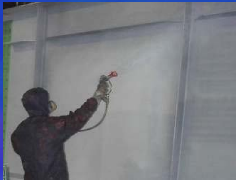
封孔処理施工状況
