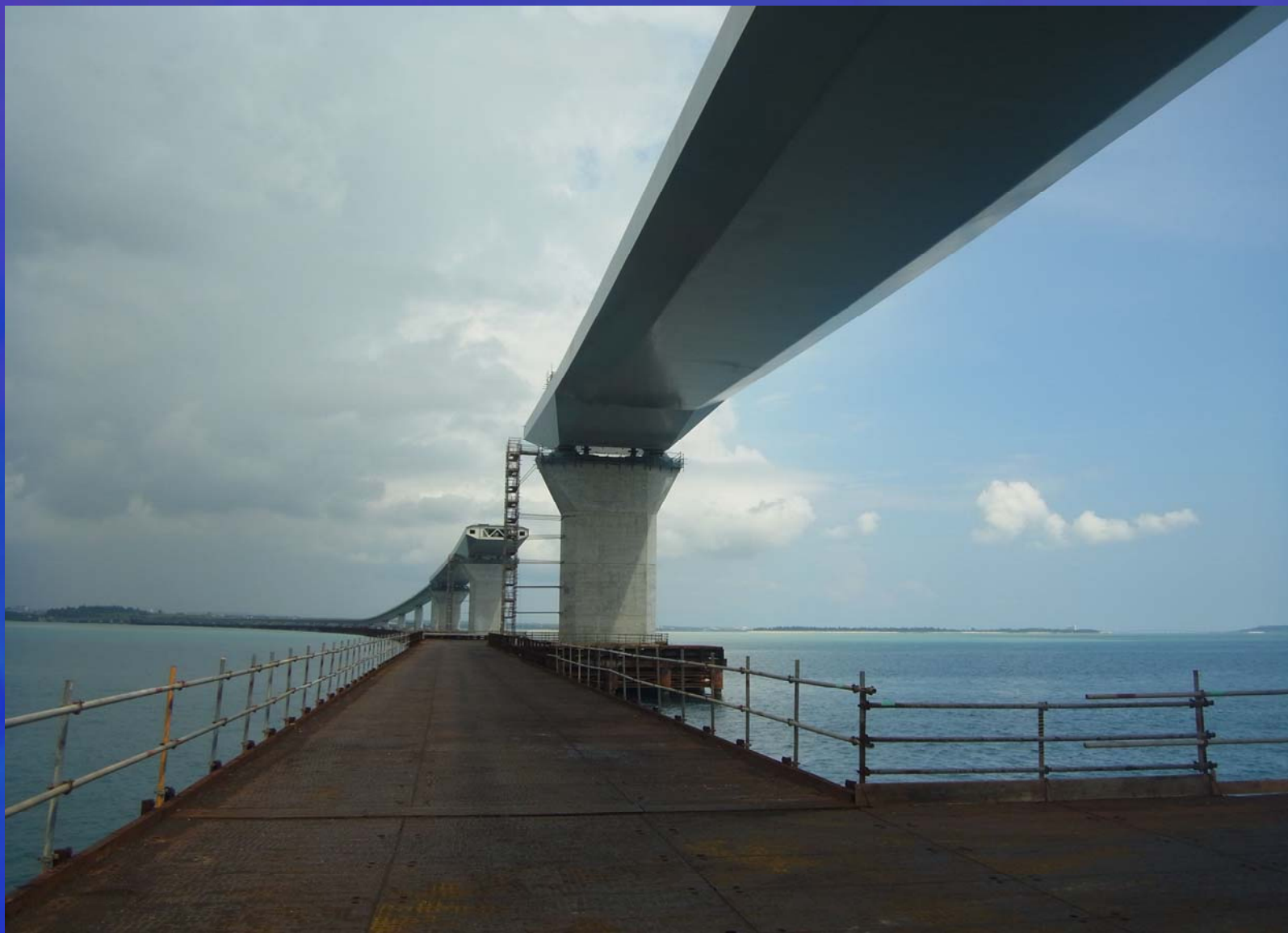
伊良部大橋 Al・Mg+塗装 (建設中)
