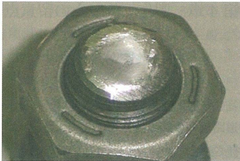
写真- II.3.1 ピンテール跡の仕上げの例
