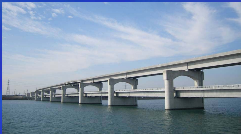
宇部小野田湾岸道路 Al+封孔処理
