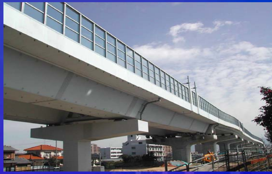
福岡都市高速: Zn-Al+封孔処理
