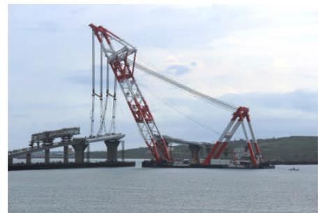
写真-11 側径間架設状況
