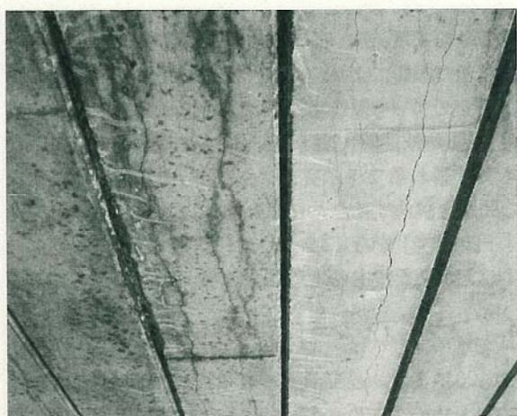
写真一4 プレテンション式PCホロー桁のASR事例(石川県, 川砂利, HOPC)
