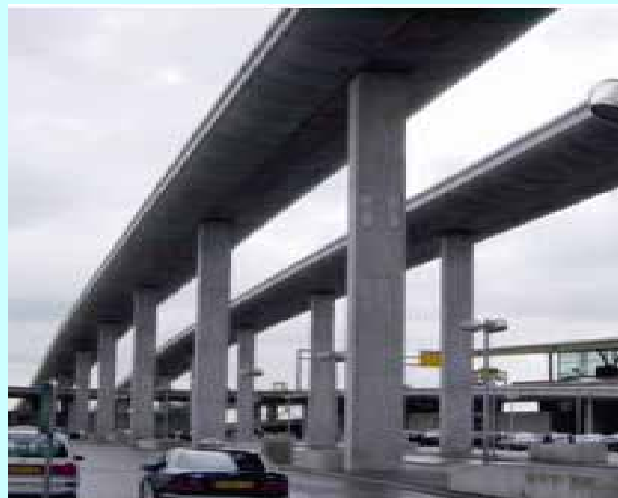
シャルル・ド・ゴール空港の アクセス道路の橋脚
