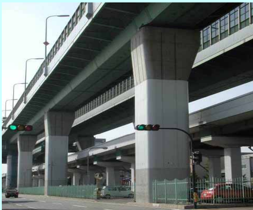
阪神高速道路の橋脚
